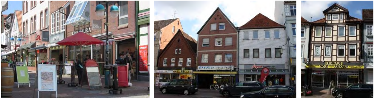
Abbildung 34: Negative Beispiele für Werbeanlagen (Zu viele Aufsteller mitten im Weg, zu grelle Farben, nicht im Verhältnis zur Fassade)
