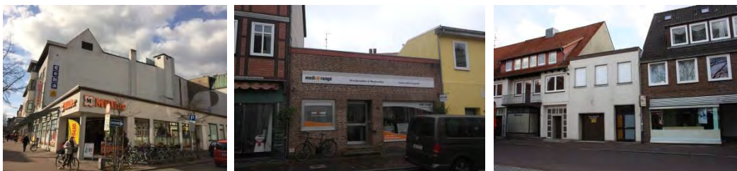
Abbildung 5: Beispiele für unzureichende Blockrandbebauung
