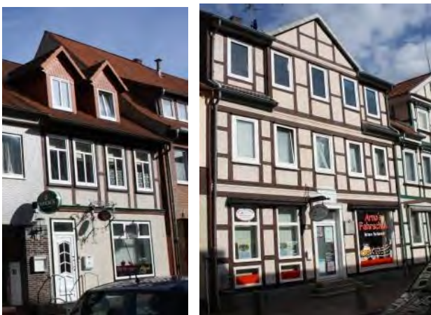
Abbildung 30: 1. Proportion der Gauben stimmt mit Proportionen des Gebäudes nicht überein 2. Gauben überprägen Dach
