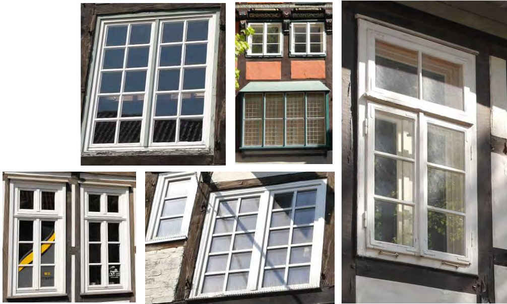
Abbildung 14: Beispiele für unterschiedliche Arten von Sprossenfenstern in Uelzen (hier Achterstraße)
