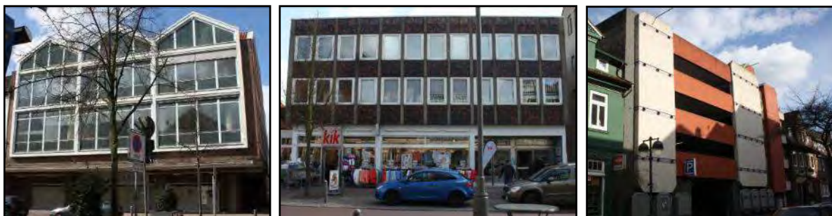
Abb. 37: Lüneburger Straße 25 - 27, Lüneburger Straße 26 – 28 und Parkhaus an der Schmiede- und Mauerstraße
