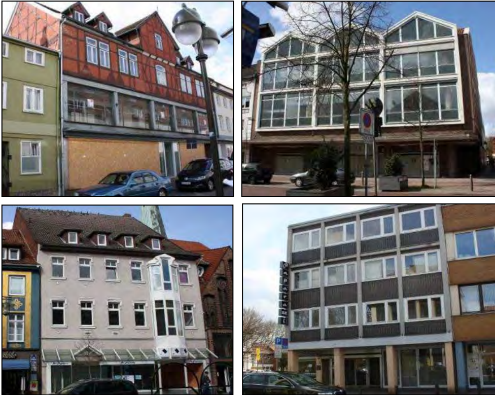
Abb. 31: Leerstehende Gebäude an der Rademacherstraße 1 (oben links), Lüneburger Straße 25 - 27 (oben rechts), Veerßer Straße 20 (unten links) sowie Gudesstraße 46 (unten rechts)
