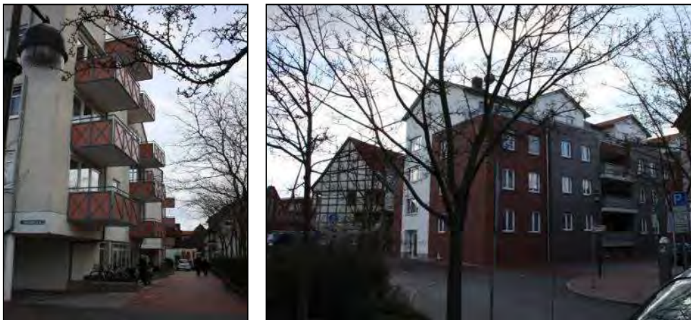
Abb. 27: Blick auf die Seniorenresidenz in der Uelzener Twiete (links); Neues MFH in der Hoefftstraße
