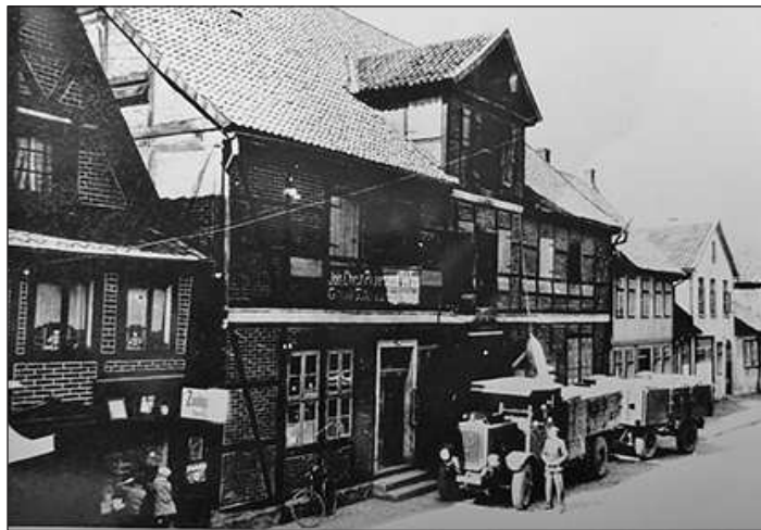
Speicher der Landhandelsfirma Joh. Chr. Praesent Wwe. an der Achterstraße, 1928 Museum Uelzen
