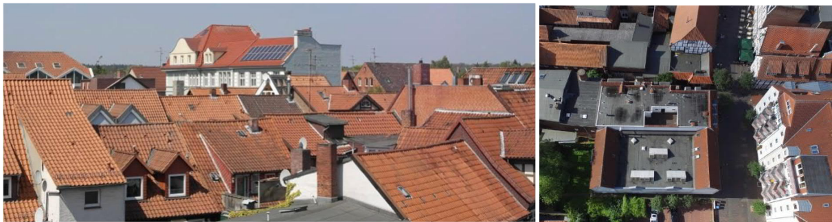
Abbildung 10: Dachlandschaft Uelzener Innenstadt, Beispiele für nicht einsehbare Flachdächer (Achterstraße)
