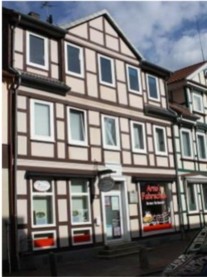
Abbildung 11: Durch Überprägung kaum noch wahrnehmbares Dachgeschoss (li.), Dachaufbauten: Schleppgaube (li. o.), Walmgaupe (re. o.), Giebelgaube (li. u.) und Zwerchhaus (re. u.)
