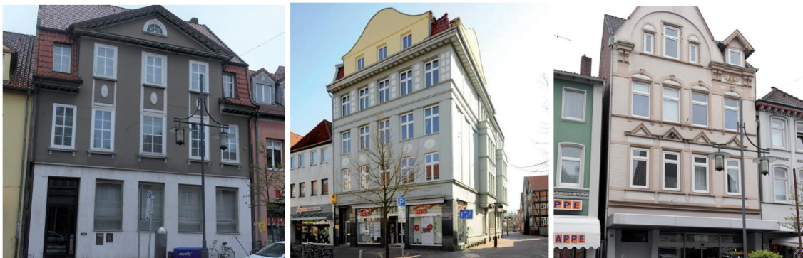
Abbildung 8: Beispiele für Gebäude mit Putzfassaden, 1. Hälfte des 20. Jahrhunderts: Lüneburger Straße 8 (Bj. um 1900), Lüneburger Straße 16 (Bj. 1910), Lüneburger Straße 37 (Bj. um 1900)
