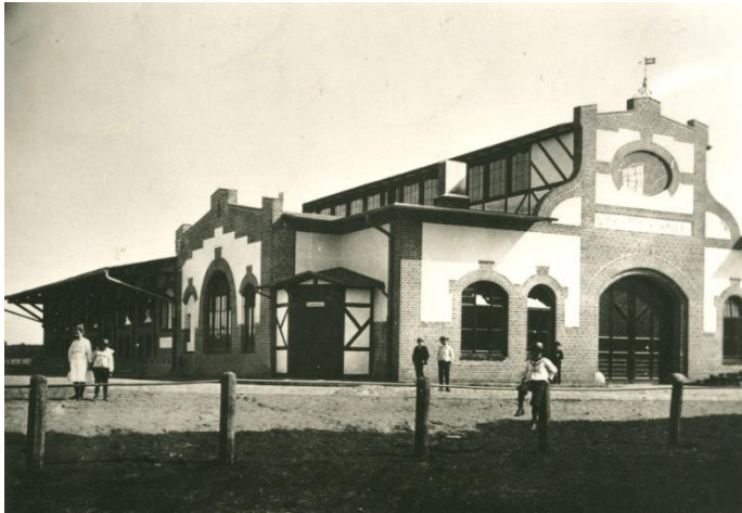
Abbildung 2: Aufnahme der alten Viehmarkthalle am jetzigen Standort des alten Kreishauses, Quelle: Hansestadt Uelzen
